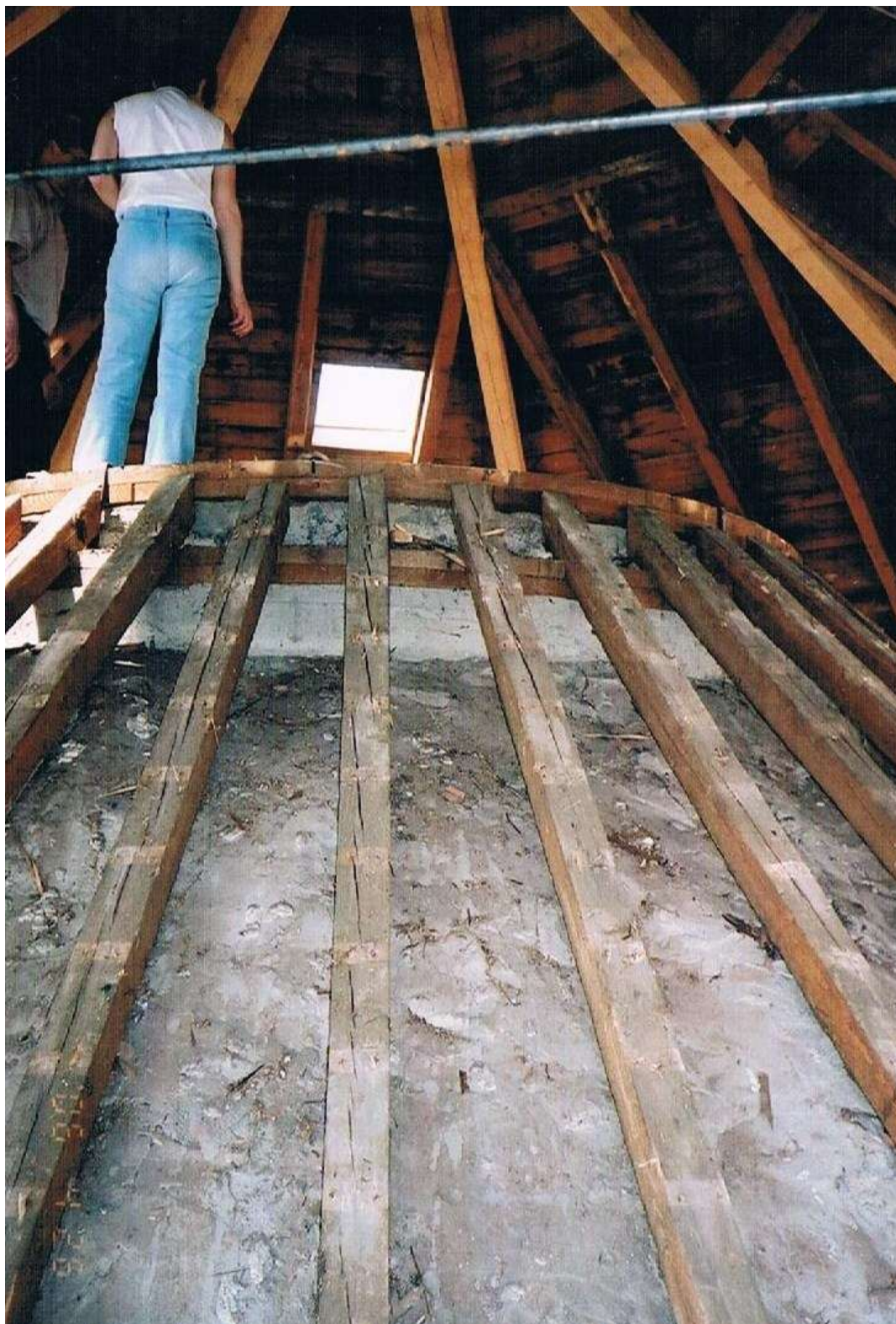
Obr. 16. Přístup k hornímu vrchlíku klenby hlavní lodi Rotundy sv. Kateřiny ve Znojmě při znaleckém posuzování v r. 2006. (celá rotunda při výměně střešní krytiny byla zakryta speciálním lešením)
