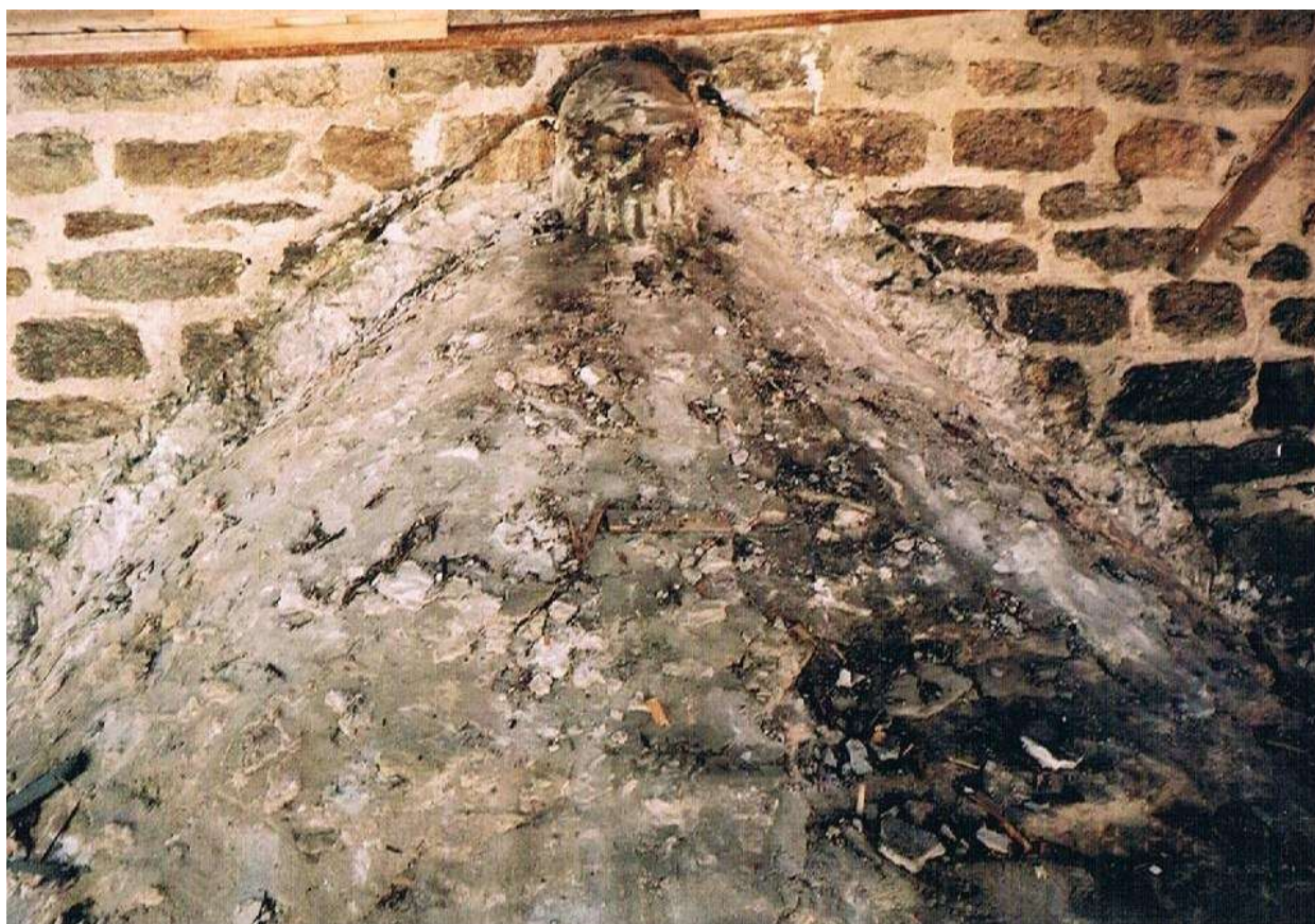
Obr. 18 Horní část zdiva vrchlíku klenby apsidy Rotundy sv. Kateřiny ve Znojmě ze stejného data 26.4.2006 jako Obr.15 a Obr.16. Zde se zkoumal po sejmutí střechy apsidy „klenák“ (závěrný kámen klenby apsidy)
