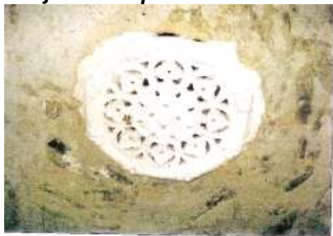
obr. 19. Románská rotunda sv. Františka Xaverského v Plavči. Detailní snímek klenebního otvoru pod lucernou. ig. 19. The Romanesque rotunda of St. Francis Xavier in Plaveč. Detailed picture of the vault opening under the lantern.
