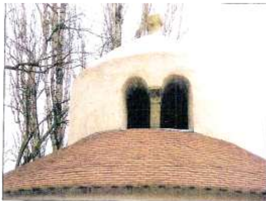
Obr. 15. Románská rotunda sv. Františka Xaverského v Plavči. Pohled na východní okno lucerny s plastikou na jejím vrcholu.
